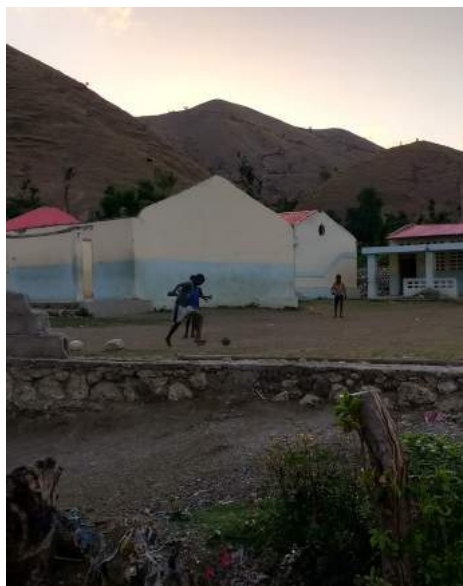
École publique sans toiture, Côteaux, février 2017
