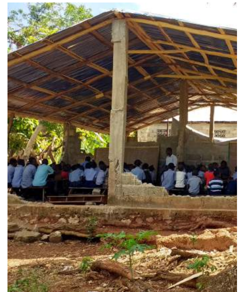
Ecole détruite à Durocher, Anse d'Hainault, février 2017
