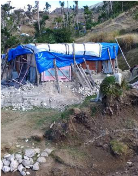
Une maison détruite aux Côteaux, février 2017
