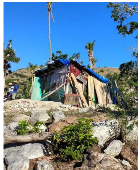
Maison détruite à Digo, Côteaux, février 2017
