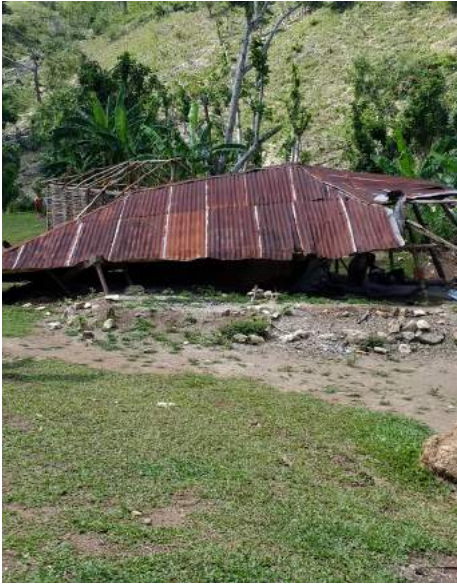
Une maison détruite à Boucan, Chambellan, février 2017
