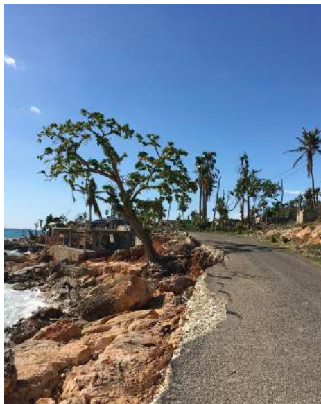
Route endommagée à Port Salut, février 2017
